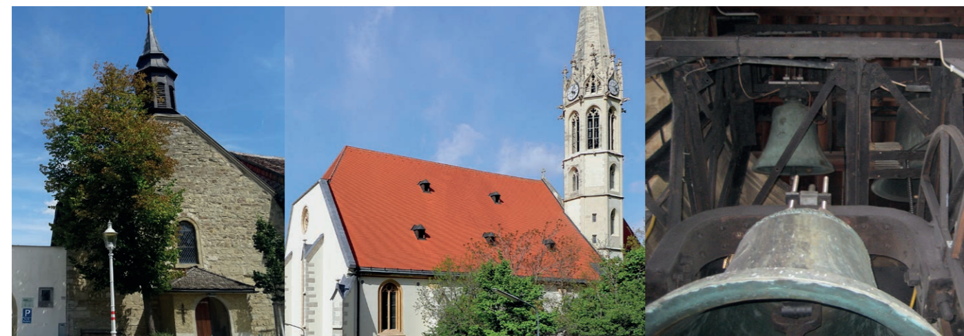
Zwei so schöne Kirchen (links: St. Jakob am Pfarrplatz, rechts: St. Michael) in einer Pfarre zu haben ist ein wertvolles Gut. Sie zu erhalten stellt für eine kleine Pfarre aber eine erhebliche Belastung dar.
